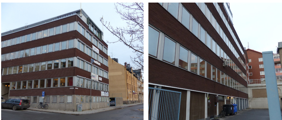
T.V: Ripan 11, bild tagen från Varvsgatan. T.H: Fasad på Ripan 11 Foto: Tyréns AB.
