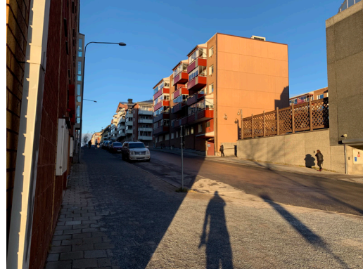
Foto (12 november 2021) på Pelikanen 12 som visar befintliga förhållanden klockan 12.06
