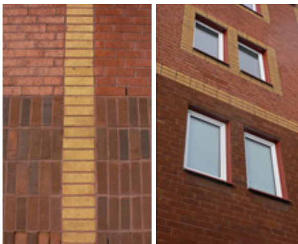
Fasad och fönster på Ripan 13. Foto: Tyrens AB
