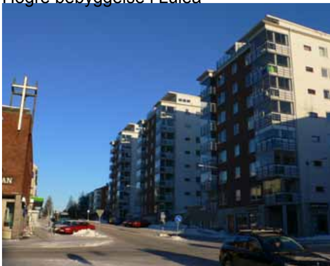
De tre punkthusen i Kv. Vesslan är ett av de nyare inslagen i centrala Luleå.
