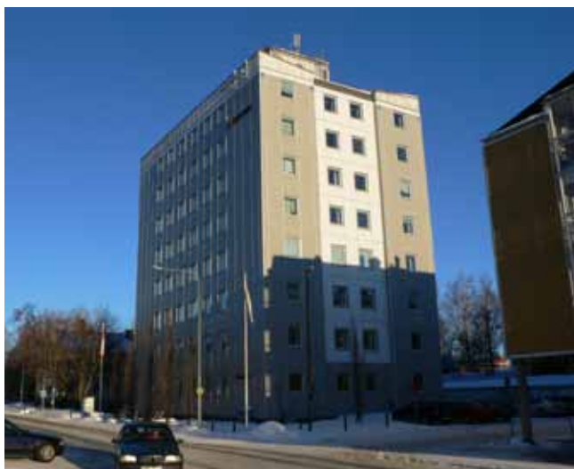
Punkthuset i Kv. Trasten (Trafikverket).
